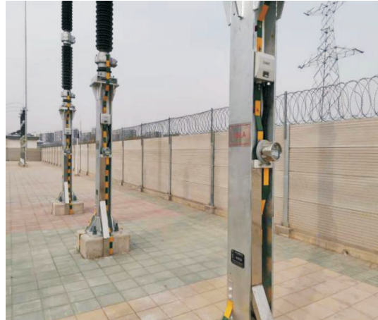
机架式母线电压监测及同步管理单元
